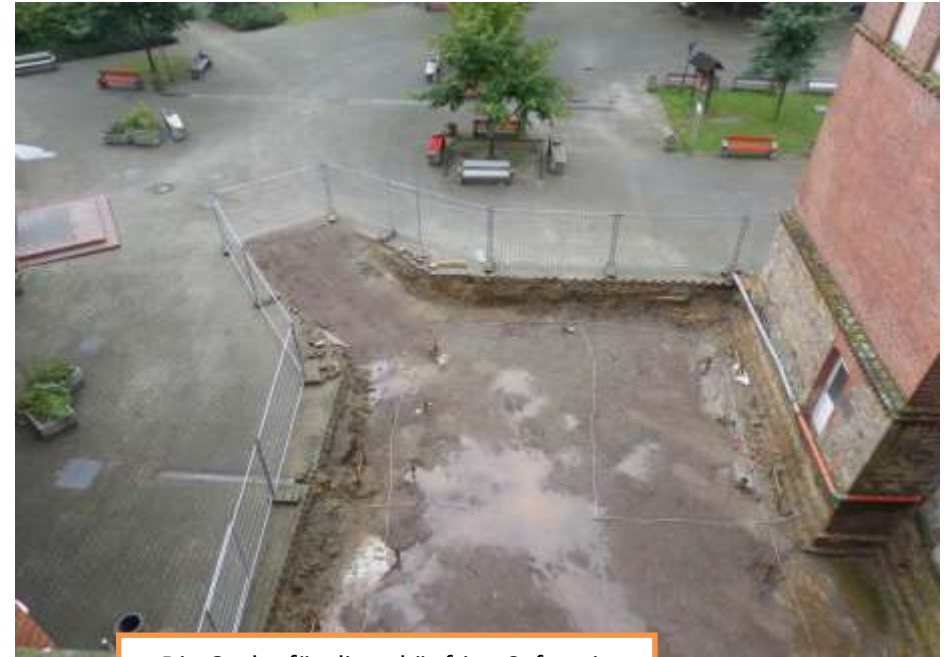
Die Grube für die zukünftige Cafeteria
