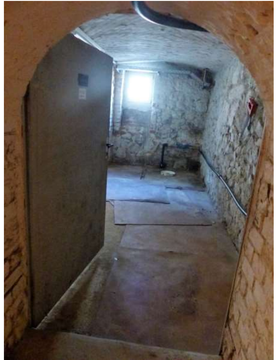
Links: seit Jahrzehnten haben sich Schüler und Bauarbeiter an den Wänden verewigt; rechts: im Kellergewölbe (Fotos: Josi)
